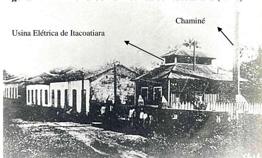
Figura 44 – Primeira Usina Elétrica de Itacoatiara (1928)
