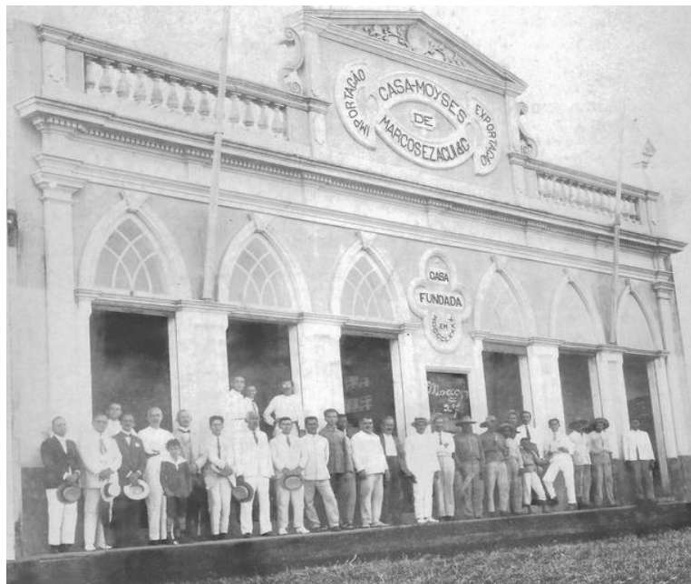
Figura 19 - Vista frontal da Casa Moisés – (1920)
