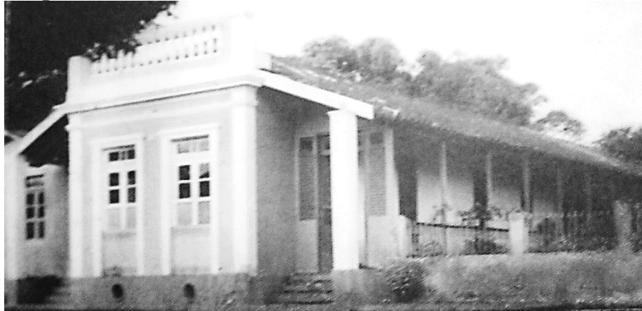
Figura 35 - Casa de Antônio de Araújo Costa no Centro, considerada padrão de época (1917)
