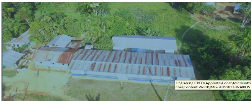
Figura 7 – Prédio da Escola Municipal Indígena Professor De'Erecü
