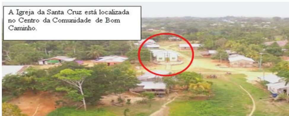
Figura 8 - Vista aérea do prédio da Igreja da Santa Cruz
